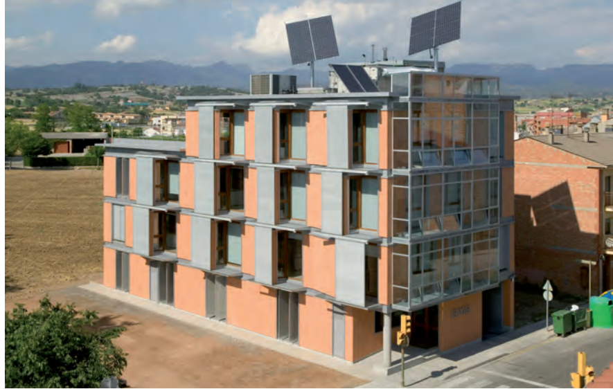
Ecoedificio La Vola (Manlleu, Barcelona) de Ecosit Arquitectes
