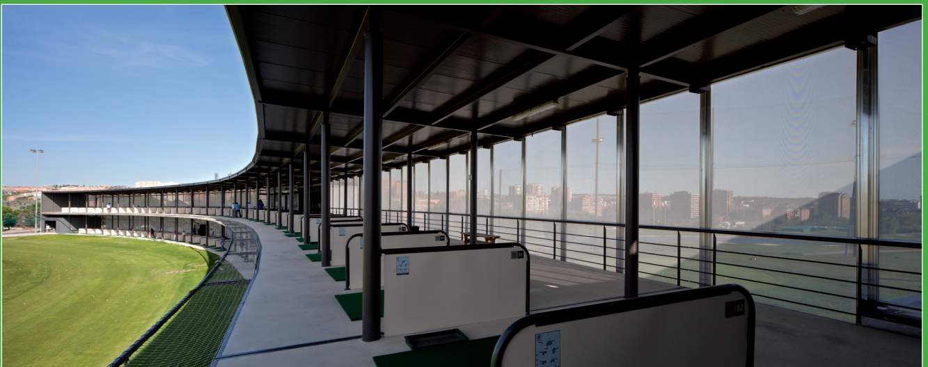
Galería de prácticas. Foto: Jaime Sicilia para Allende Arquitectos.
